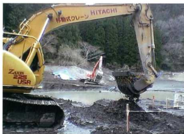
攪拌改良状況
